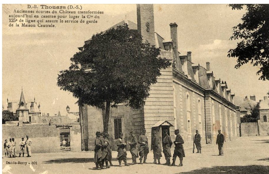
Ecuries transformées en caserne (vers 1910) ve(1900)
