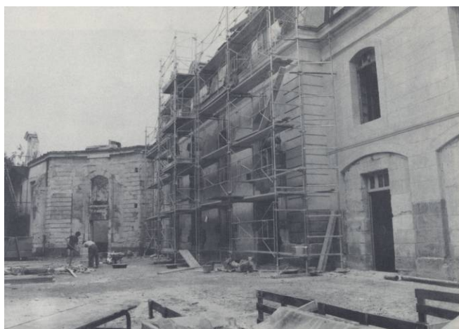
Reconstruction des écuries en 1988 (1989)
