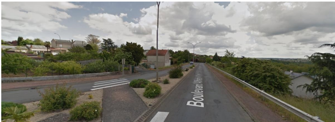
Vue de la zone au nord (boulevard Alfred de Vigny)
