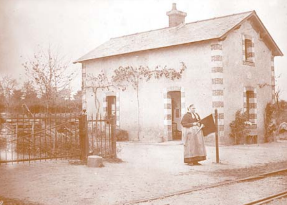
Exemple type d'une maison de garde-barrière, vers 1910. Coll. Musée Henri Barré.
