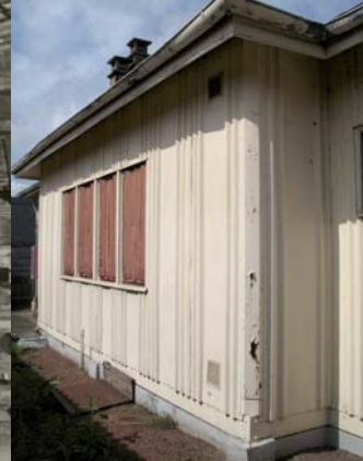
6 Détails des parements métalliques d'origine. Coll. Ville de Thouars.
