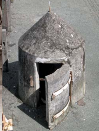
6 Guérite en béton armé servant d'abris en cas d'attaques aériennes. Coll. Ville de Thouars.
