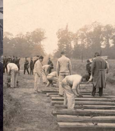
Pose des voies du dépôt de munitions, vers 1916. Coll. E. et S. Cadu.
