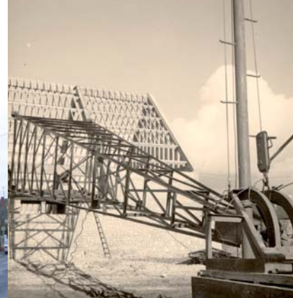
Montage de la charpente du clocher de l'église Notre-Dame du cottage en 1959. Coll. Pinel.
