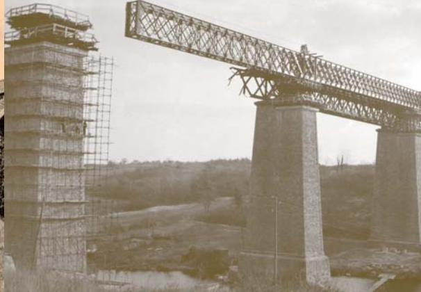
Pose du nouveau tablier en 1947. Coll. M. Olivier.
