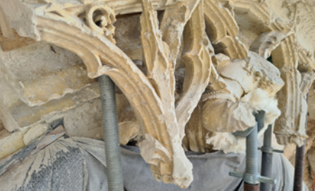
Restauration de la Collégiale
