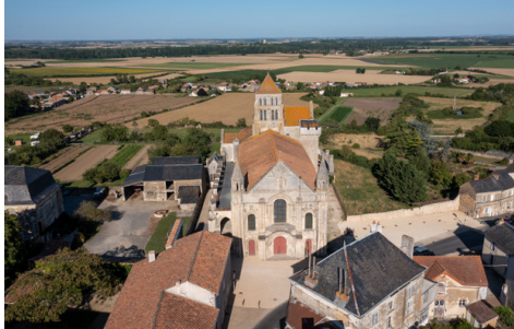
Vue aérienne de Saint-Jouin-de-Marnes
